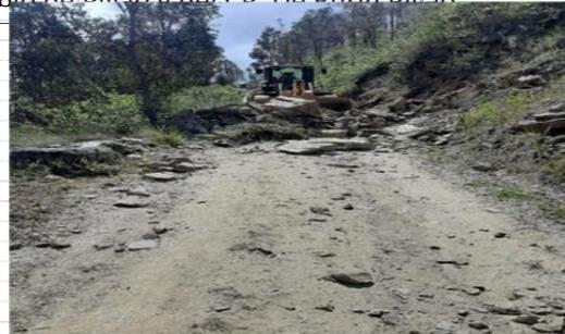
Foto 04: Prog Km: 00+350, Como se puede observar se están realizando trabajos de remoción de derrumbe, foto durante los trabajos.
