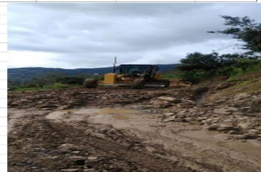
Foto 05: Prog Km: 00+850, Como se puede observar se están realizando trabajos de remoción de derrumbe, foto durante los trabajos.
