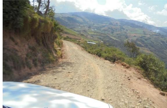
Foto 02: Prog Km: 06+000, Fin del tramo el terreno es accidentado y está en mal estado.
