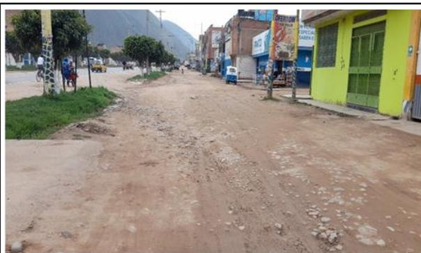
FOTO 03: COMO SE PUEDE OBSERVAR LA CALZADA ESTA EN PESIMAS CONDICIONES
