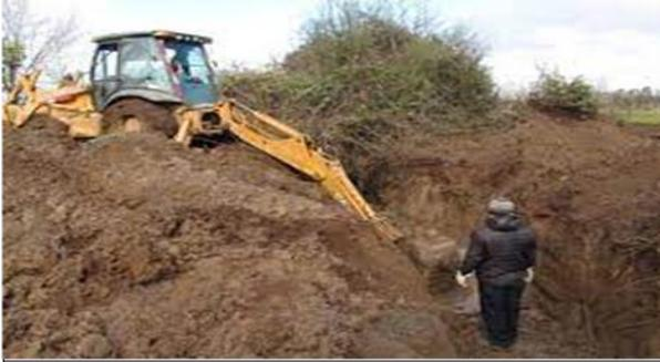
**Foto 01: Prog: 01+260, Derrumbe N° 01-DURANTE:** En la imagen se puedes observar la culminacion de la limpieza de derrumbe. TRAMO: Chacchapata - Luichupampa
