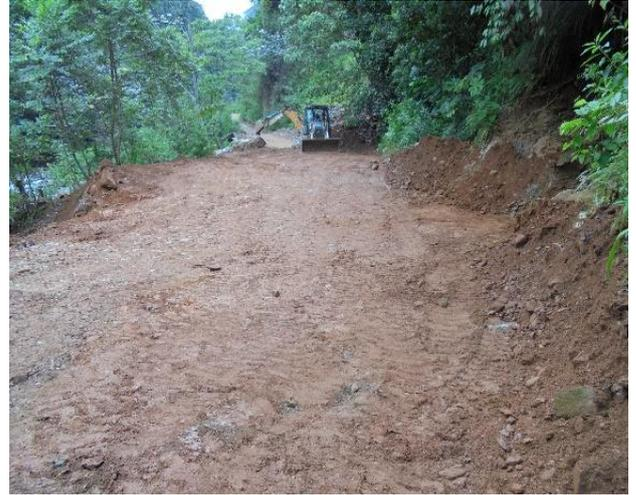
**Foto 06: Prog: 02+244, Como se puede observar se continúan con los trabajos de limpieza de Huayco que colmato al Badén (Después).**
