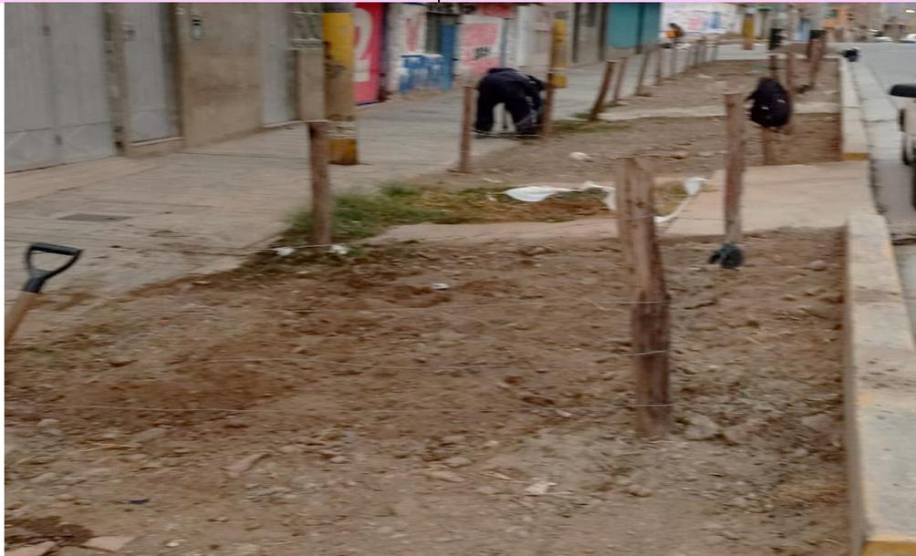
**Imagen N°29:** Instalación de cerco de alambre de púas en la Av. Circunvalación
