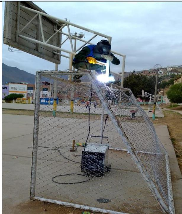
**Imagen N°27: Reparación de la malla del arco de Futbol.**
