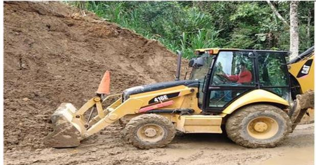
**Foto 06: Prog: 00+100, Derrumbe N° 05-DURANTE:** En la imagen se puedes observar la culminacion de la limpieza de derrumbe. TRAMO: Guegayog - Lanjas Alta
