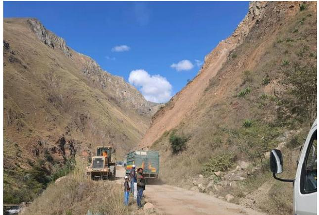
**Foto 01: Prog: 01+380 al 01+443,** Como se puede apreciar el tramo se encuentra intransitable por derrumbes ocurridos por fuertes lluvias.
