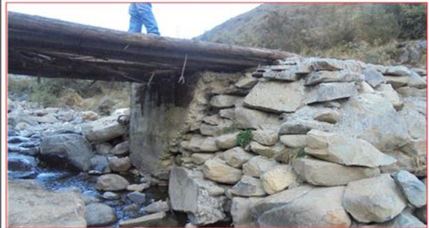
Foto 02: Vista fotografica de estribo derecho del puente
