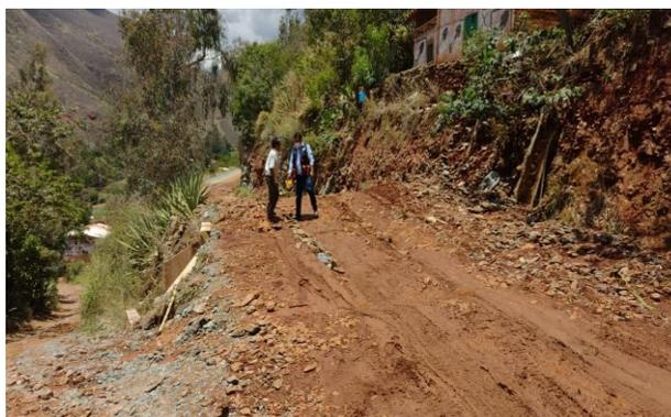
**Foto 01: Prog: 05+880, Huayco N° 01:** Como se observa el tramo esta intransitable por las fuertes precipitaciones ocurridos en el presente año; C.P. Ingenio (vista adelante)
