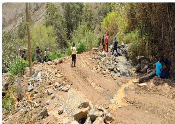
**Foto 02: Prog: 06+930, Huayco N° 03:** Como se observa el tramo esta intransitable por las fuertes precipitaciones ocurridos en el presente año; Barrio Mercenario (vista adelante)
