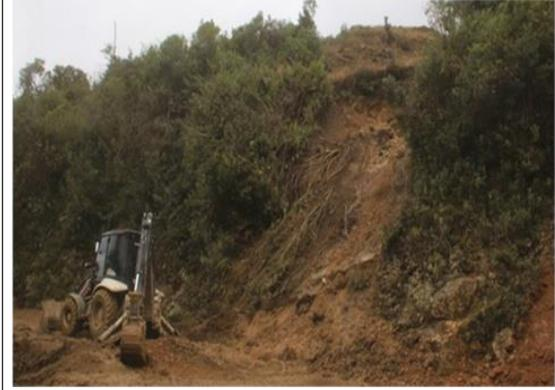
**Foto 08: Prog: 32+062,** Como se puede observar se estan realizando trabajos de limpieza de derrumbe.
