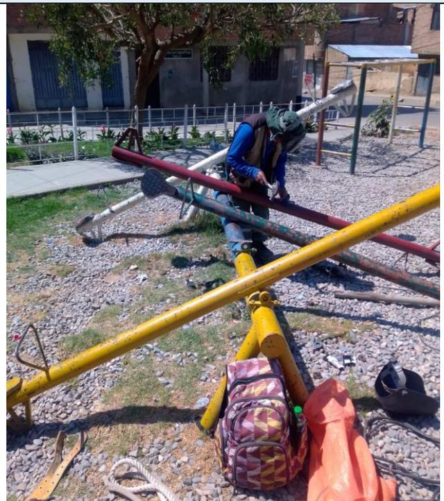
**Imagen N°28: Reparación del Sube y baja.**
