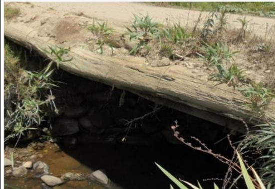
**Foto 02:** Vista fotografica de estribo derecho del puente de manposteria de piedra
