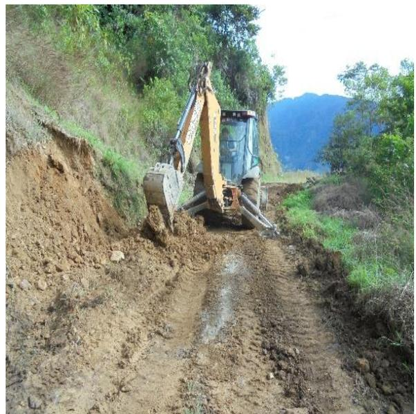
**Foto 09:** Prog: 11+120, Como se puede observar se continuamos con los trabajos de limpieza de Derrumbe (Durante).
