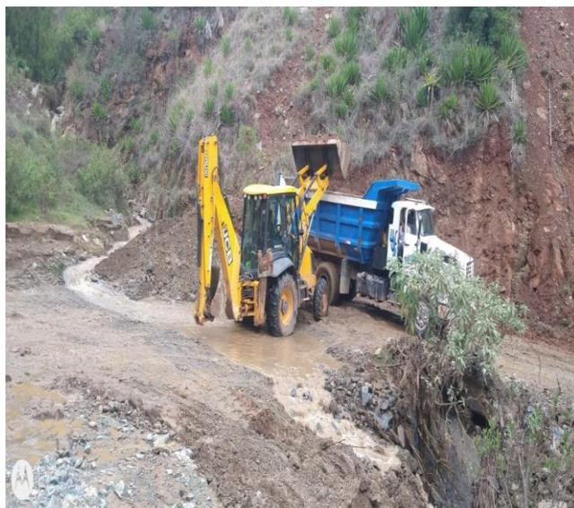
**Foto 07: Prog: 01+720, Huayco N° 05:** Como se observar las maquinas limpiando el tramo Pomacucho (foto durante los trabajos).
