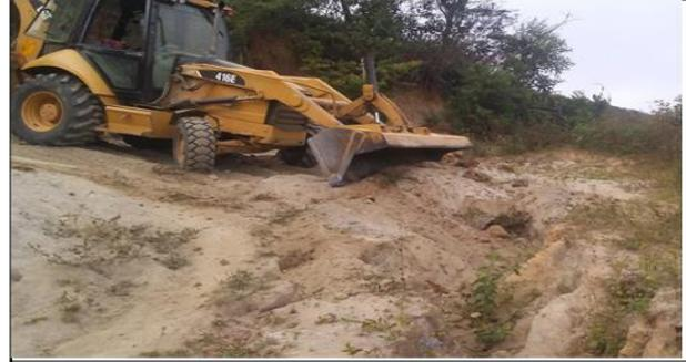
**Foto 02: Prog: 01+260, Derrumbe N° 01-DURANTE:** En la imagen se puedes observar la culminacion de la limpieza de derrumbe. TRAMO: Chacchapata - Luichupampa
