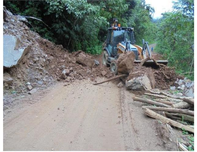
**Foto 05: Prog: 02+571, Huayco N° 03, como se puede observar se continúan con los trabajos de limpieza de Huayco (Durante).**
