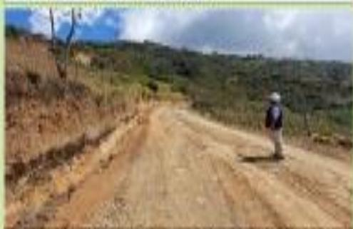
Foto 10: Prog. Km: 01+750 y Km: 01+300, Como se puede apreciar verificando los trabajos conformación de cuneta y limpieza de calzada.
