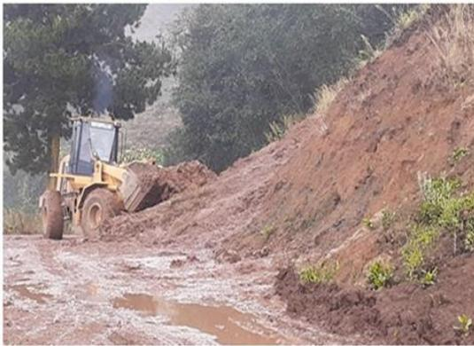
**Foto 07: Prog: 30+062,** Como se puede observar se estan realizando trabajos de limpieza de derrumbe.
