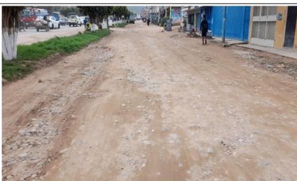
FOTO 06: COMO SE PUEDE OBSERVAR LA CALZADA ESTA EN PESIMAS CONDICIONES
