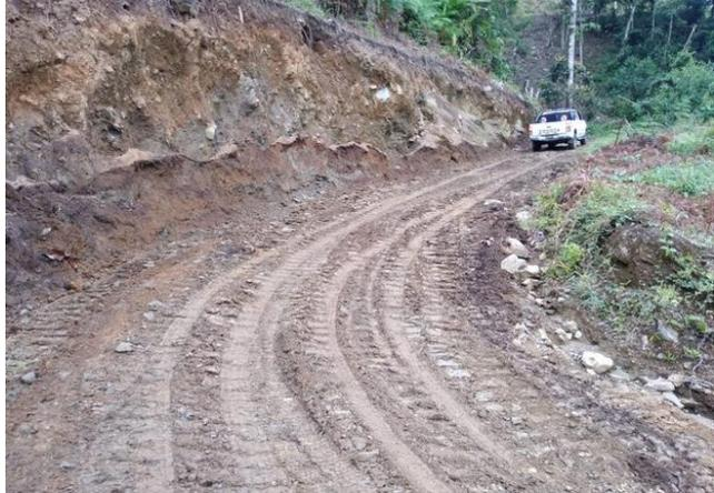
**Foto 03: Prog: 33+183, Derrumbe N° 10: Como se observa continuamos con los trabajos de limpieza de derrumbe.**
