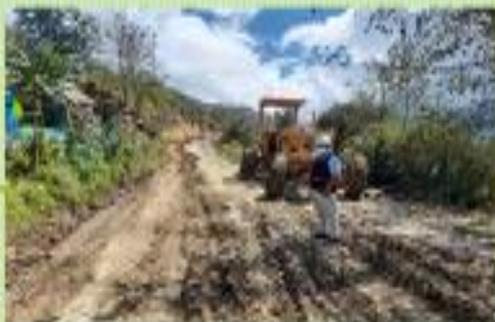
Foto 06: Prog Km: 3+100, como se puede observar se están realizando trabajos de limpieza de cuneta, foto durante los trabajos.
