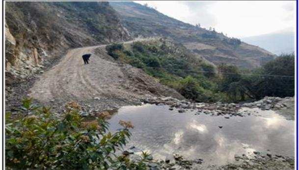
**Foto 02:** Vista panorámica del estribo izquierdo del puente Chacarragra aguas abajo, conformado por mampostería de piedra (mampostería de piedra).
