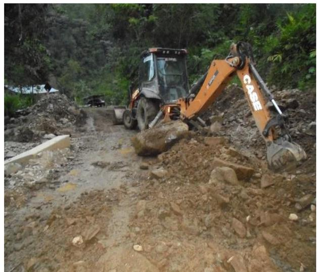
**Foto 04: Prog: 00+612, Huayco N° 02, como se puede observar se continúan con los trabajos de limpieza de Huayco (Durante).**
