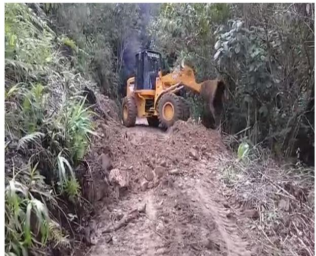
**Foto 08: Prog: 06+749**, Como se puede observar se continúan con los trabajos de limpieza de Derrumbe (Durante).
