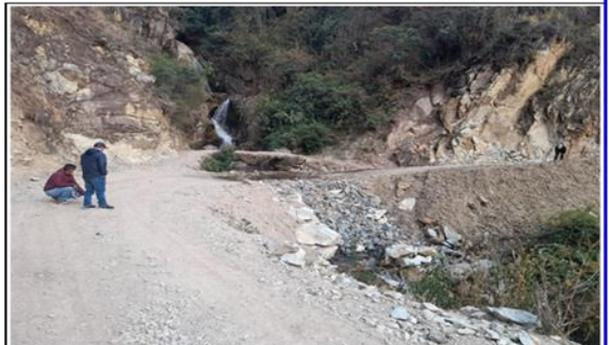
**Foto 06:** Vista panorámica aguas arriba del puente Chacarragra como se puede observar recientemente la plataforma conformado por madera rolliso y entablado colapso debido a las fuertes precipitaciones de la zona.
