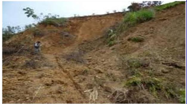
**Foto 04:** Prog: 00+100, Derrumbe N° 02: como se observa la mano de obra de los comuneros no es suficiente para limpiar el derrumbe. TRAMO: Guegayog - Lanjas Alta
