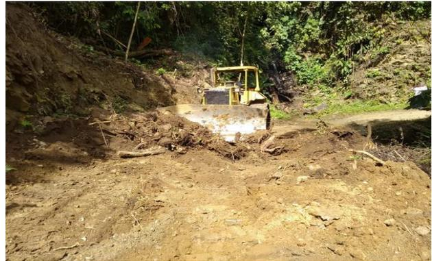
**Foto 02: Prog: 33+175**, Derrumbe N° 04: Como se observa puede observar se iniciaron con los trabajos de limpieza de derrumbe.
