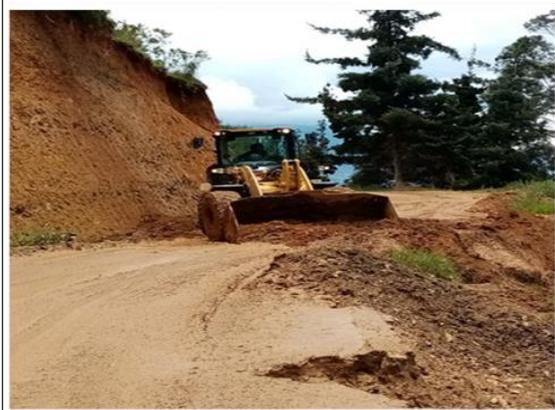
**Foto 10: Prog: 35+243,** Como se puede observar se estan realizando trabajos de limpieza de derrumbe.
