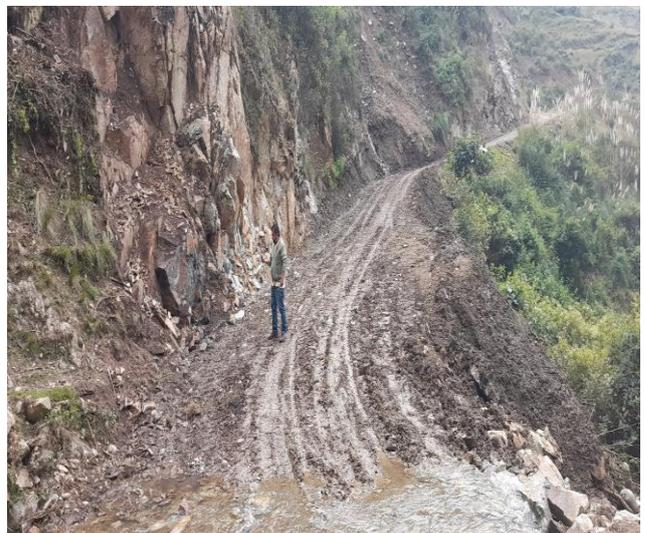
**Foto 02: Prog: 01+380:** Como se observa continuamos con los trabajos de limpieza de derrumbe.
