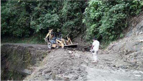
**Foto 03: Prog: 02+560, Derrumbe N° 02-DURANTE:** Se observa el inicio de las actividades de limpieza de derrumbe. TRAMO: Chacchapata - Luichupampa
