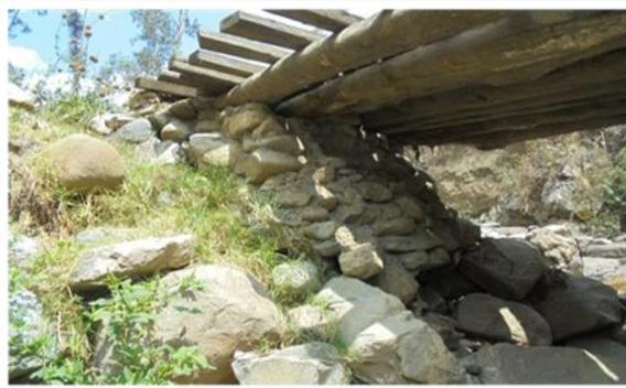
Foto 02: Vista fotografica de estribo derecho del puente
