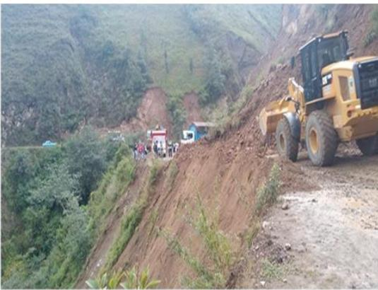
**Foto 09: Prog: 35+033,** Como se puede observar se estan realizando los trabajos de limpieza de derrumbe.
