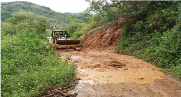
**Foto 05: Prog: 00+100, Derrumbe N° 05-DURANTE:** En la imagen se puedes observar la culminacion de la limpieza de derrumbe. TRAMO: Guegayog - Lanjas Alta
